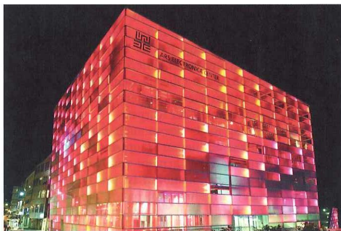
Bild 3. Die teils transparenten und teils transluzenten Glasflächen werden vom Fassadenzwischenraum aus mit LED hinterleuchtet (Fotos: GIG FASSADEN GmbH)
